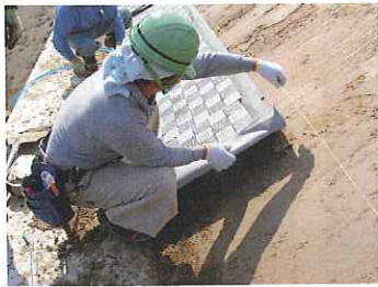
2. ブロック設置
